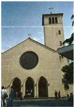
お馴染みの現聖堂正面ですが、新聖堂の工事のためにもうこの方向からは、見る事ができなくなりました。
